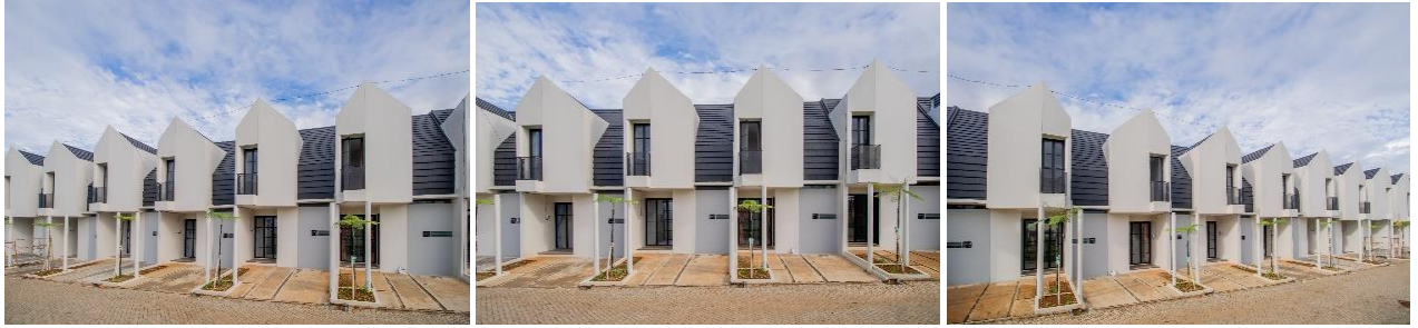
Gambar Progres Pembangunan Unit Greenland Kemang
