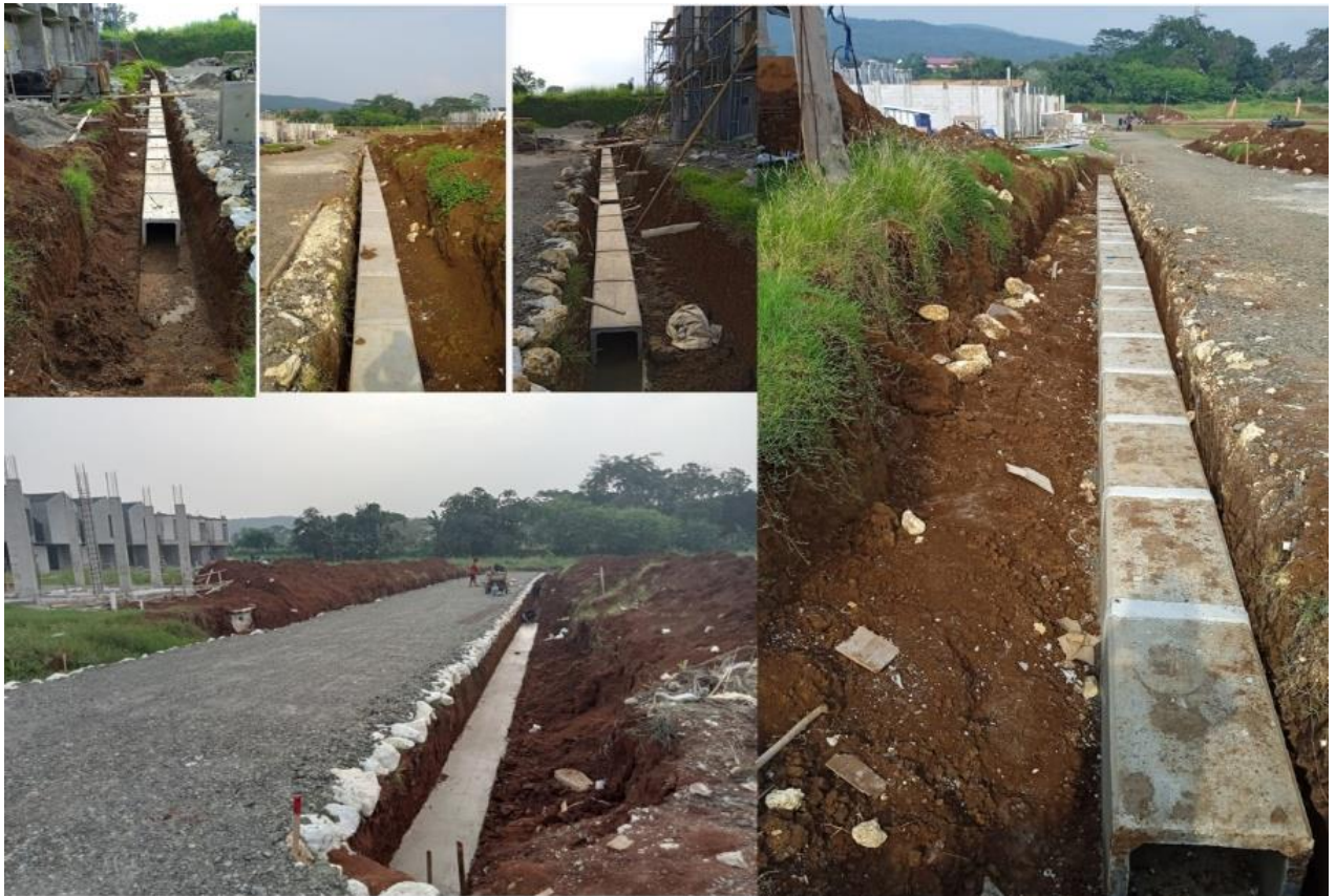
Gambar Pekerjaan Saluran Greenland Kemang
