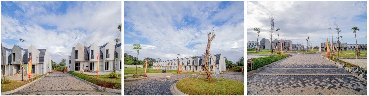
Gambar Pekerjaan Paving Jalan Utama Greenland Kemang
