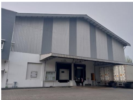
COLD STORAGE DAN TEMPAT LOADING KONTAINER EKSPOR
